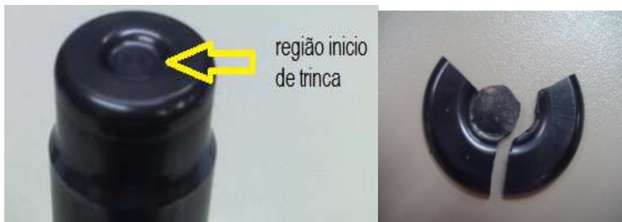
Bild 25: Ort und Ausbreitung der Risse
